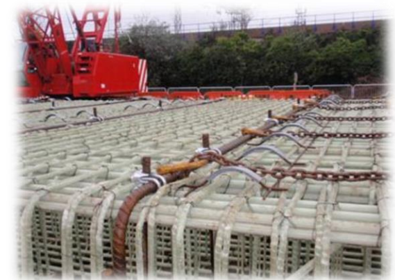
Glasspre® E46 stirrups and bent bars
